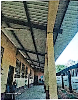
Foto 1: CAMBIO DE PINTURA
